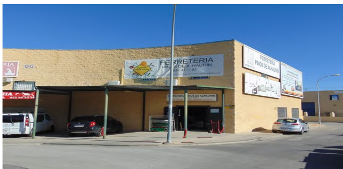
Foto 1. Vista de la estructura objeto del expediente
