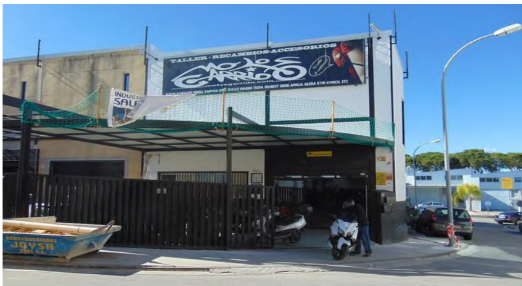
Foto 1. Vista de la estructura objeto del expediente
