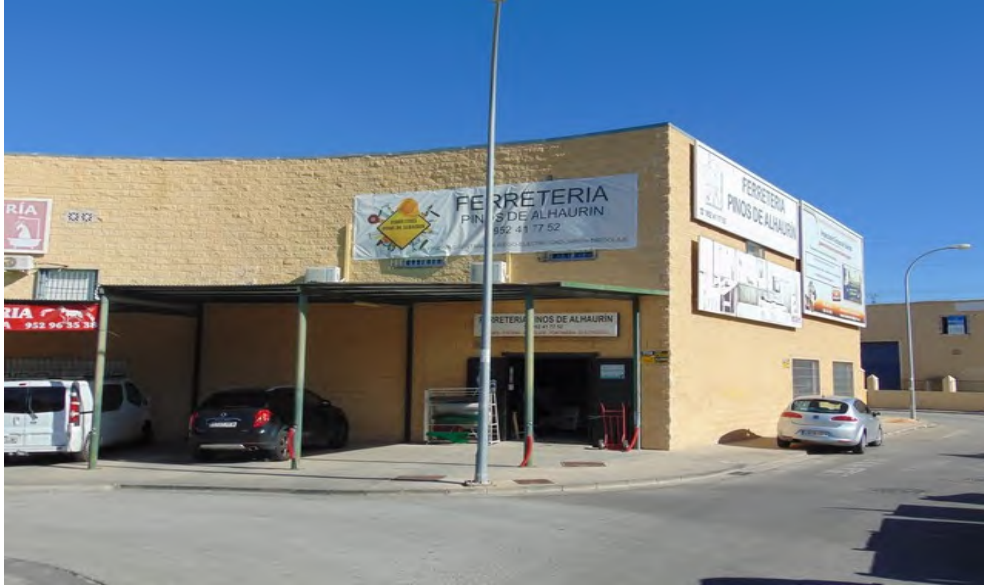
Foto 1. Vista de la estructura objeto del expediente
