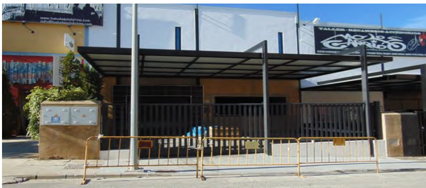
Foto 1. Vista de la estructura objeto del expediente
