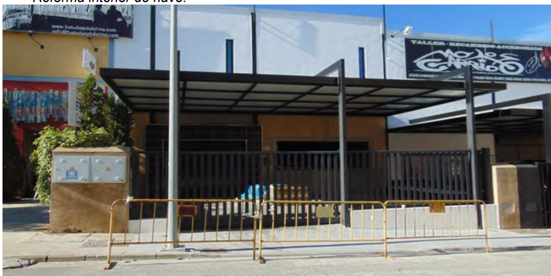
Foto 1. Vista de la estructura objeto del expediente
