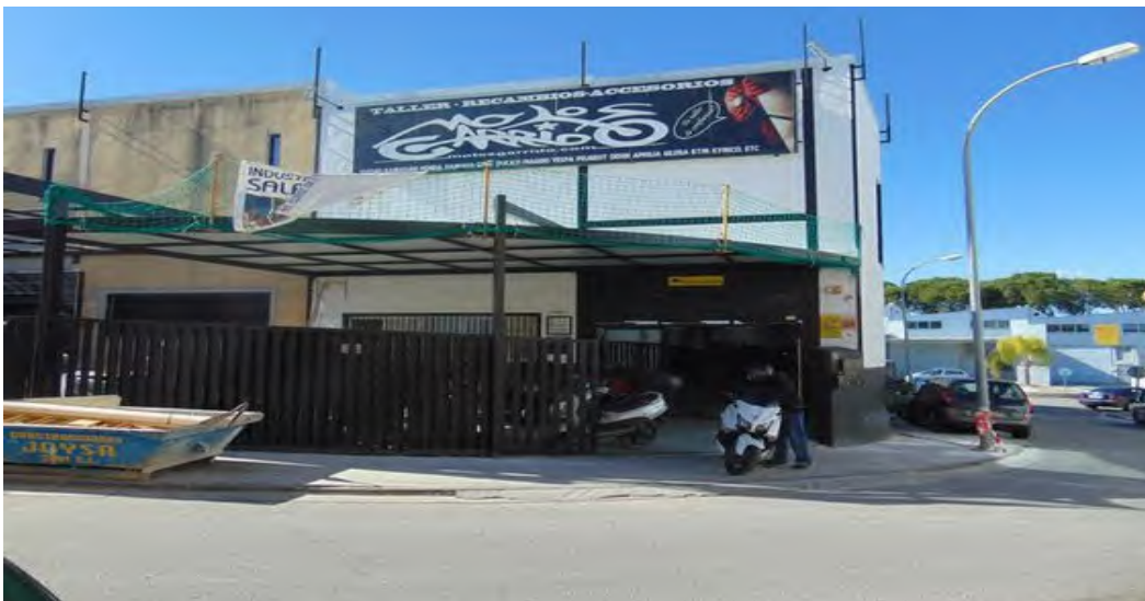
Foto 1. Vista de la estructura objeto del expediente
