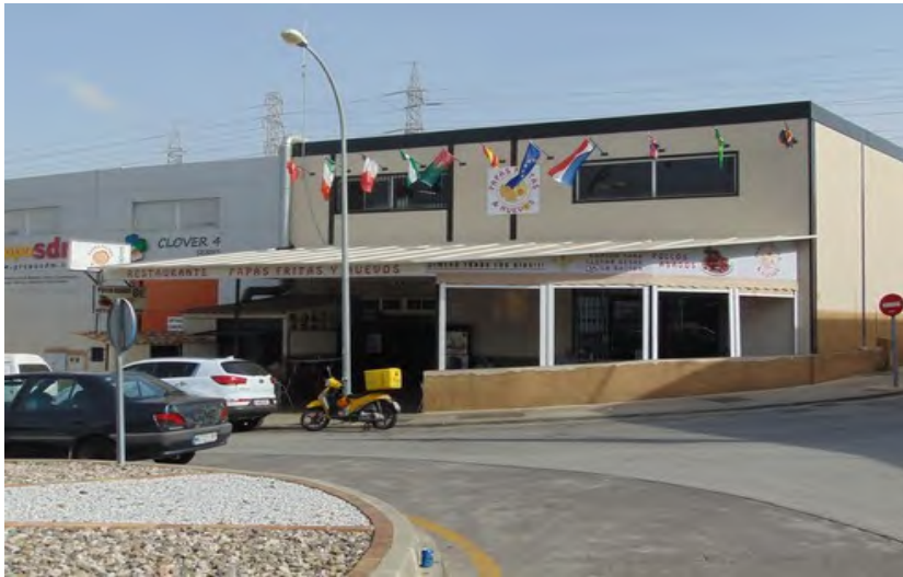
Foto 1. Vista de la estructura objeto del expediente
