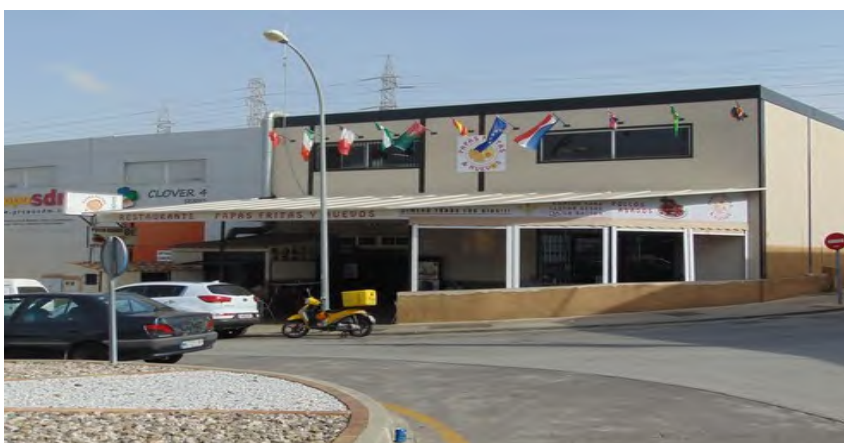
Foto 1. Vista de la estructura objeto del expediente
