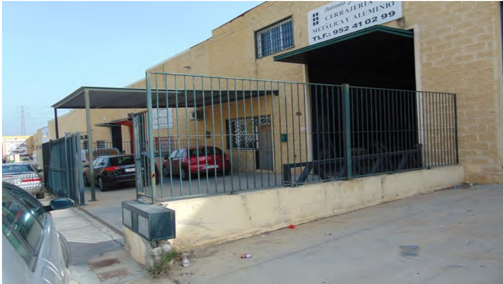
Foto 1. Vista de la estructura objeto del expediente
