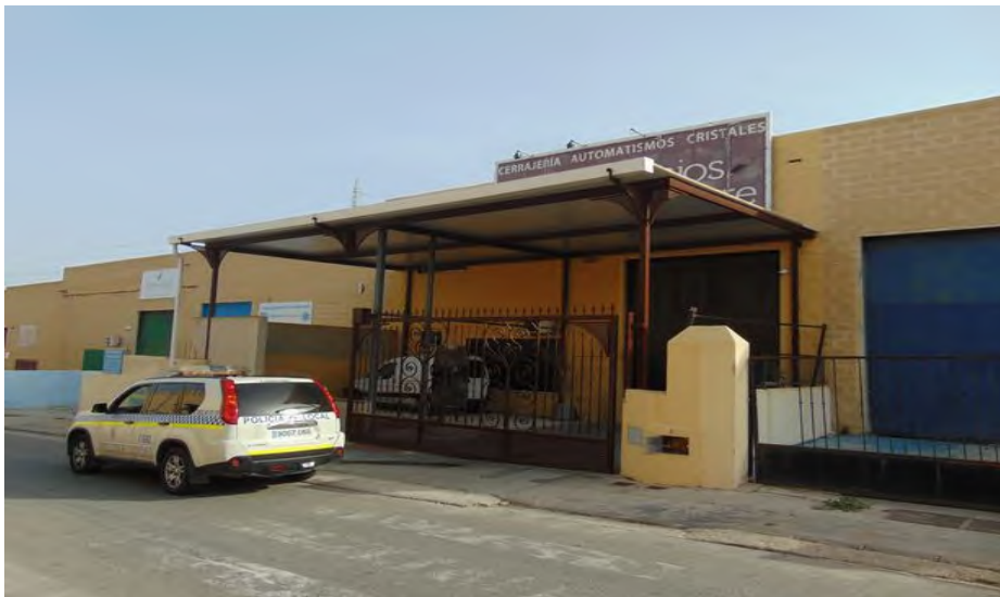
Foto 1. Vista de la estructura objeto del expediente
