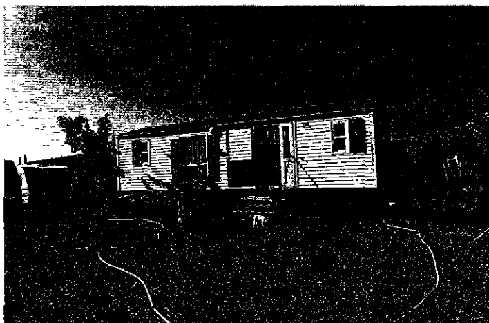
Foto 1. Vista exterior de la vivienda prefabricada denunciada.
