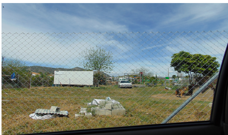
Foto 1. Vista exterior de la estructura metálica denunciada.
