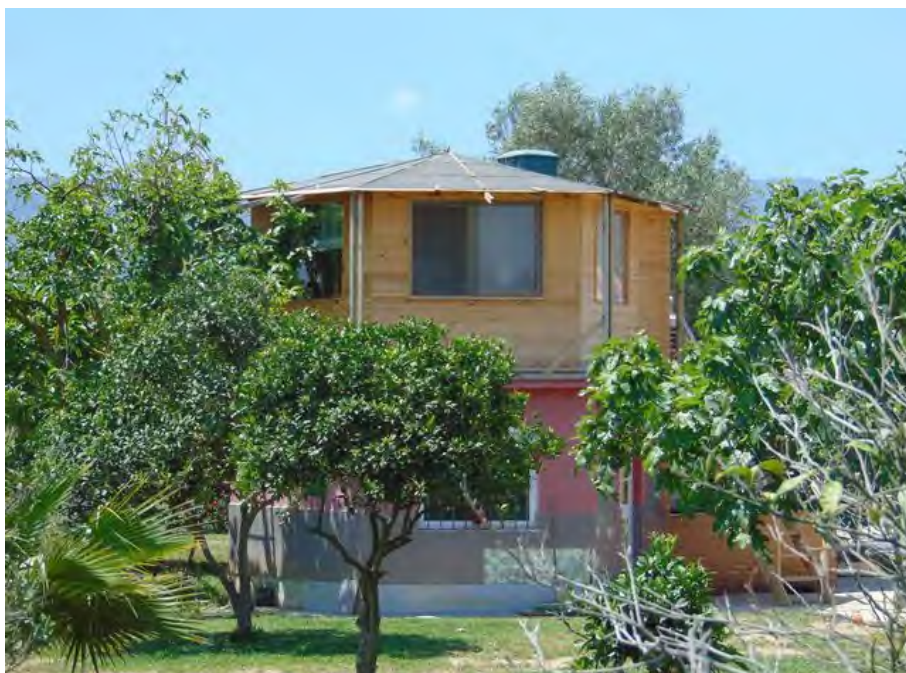
Foto 2. Vista exterior de la vivienda denunciada.
