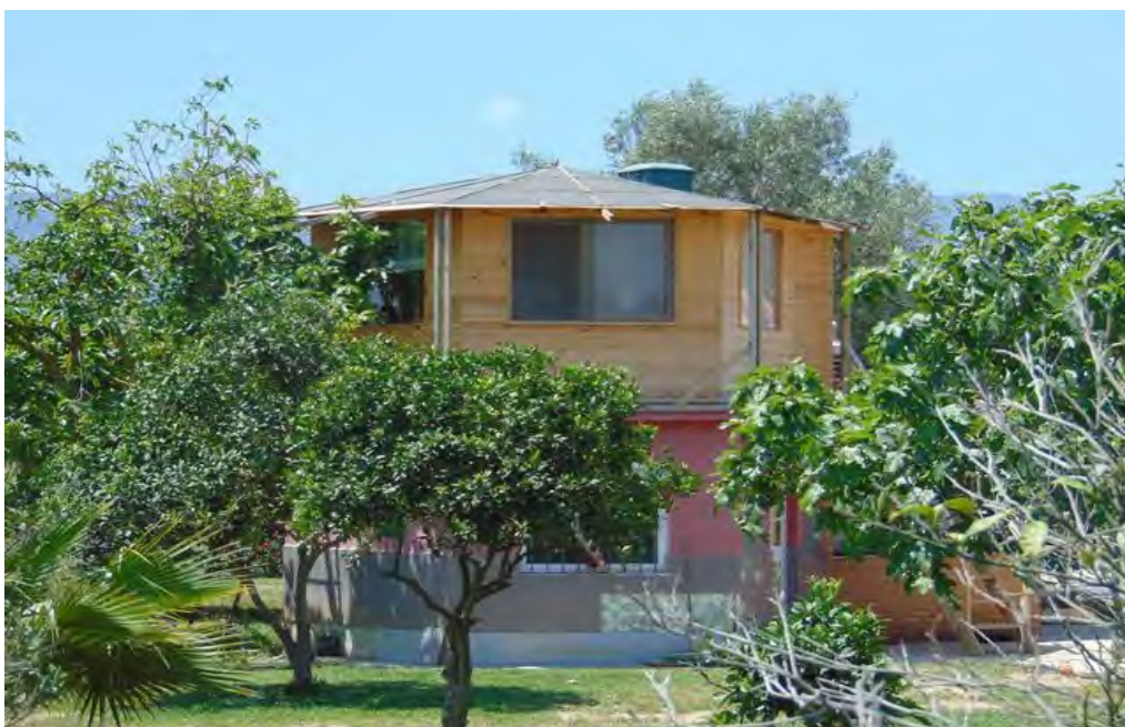
Foto 2. Vista exterior de la vivienda denunciada.
