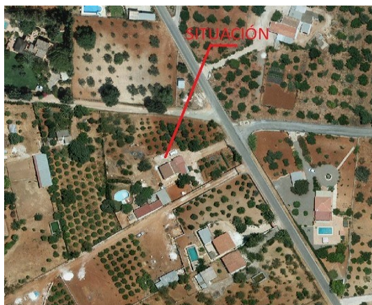
Fotografía aérea de la parcela donde se observan las edificaciones de fecha Julio de 2005
