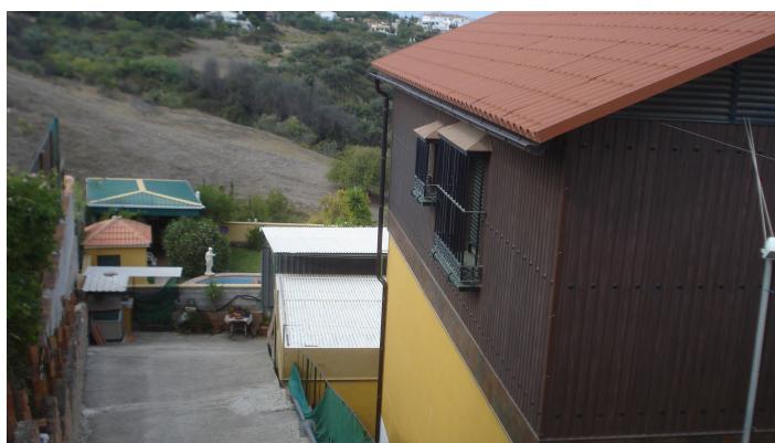
Foto 2. Vista donde se observa el desnivel de la parcela con la planta semienterrada
