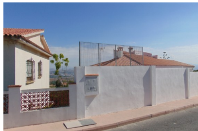
Vista 1 vallado a vía pública
