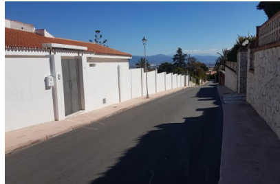
Vista 2 vallado a vía pública
