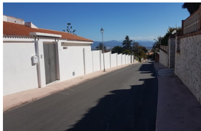
Vista 2 vallado a vía pública
