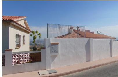
Vista 1 vallado a vía pública
