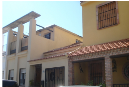
Fotografía de la vivienda sita en C/ Sarmiento nº 7 (A la izquierda de la imagen, donde se puede observar el cierre del porche en planta baja y la ampliación de la vivienda en planta alta
