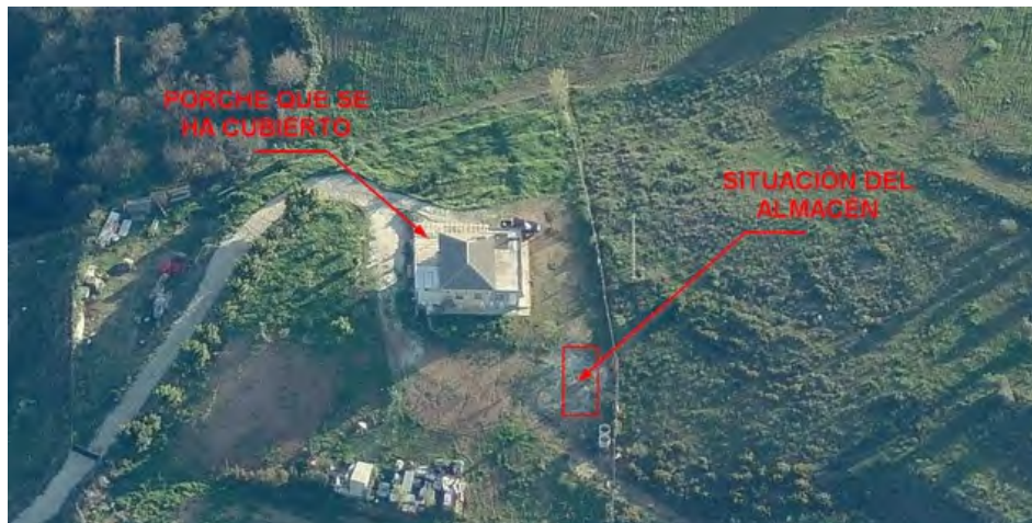
Estado de la parcela previo a la construcción de las obras objeto del expediente obtenidas del programa GOOLZOOM
