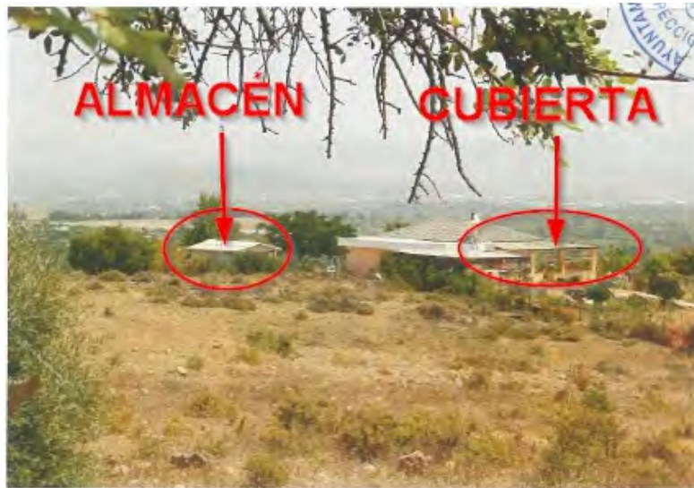
Fotografías realizadas durante la visita de inspección referida de fecha 05/08/2016, situando las edificaciones objeto del expediente (almacén y cubierta de porche)
