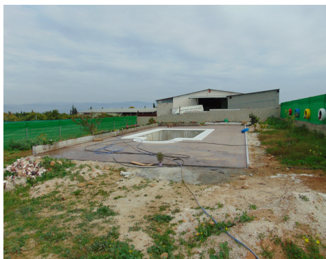
Foto 2. Vista de la piscina y de la solera perimetral realizada.
