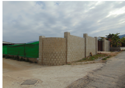
Foto 1. Vista del vallado delantero.
