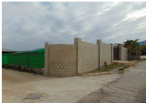
Foto 1. Vista del vallado delantero.
