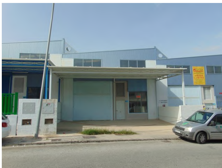
Foto 1. Vista de la estructura objeto del expediente
