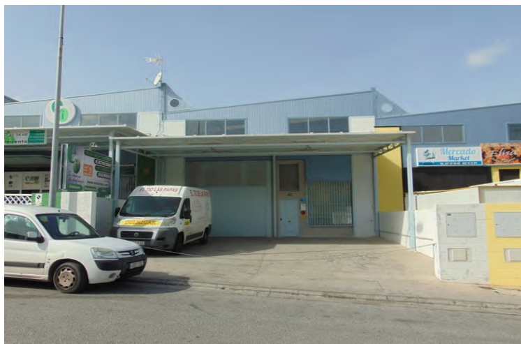
Foto 1. Vista de la estructura objeto del expediente
