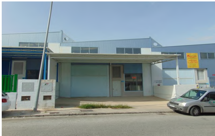
Foto 1. Vista de la estructura objeto del expediente
