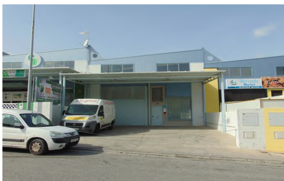
Foto 1. Vista de la estructura objeto del expediente
