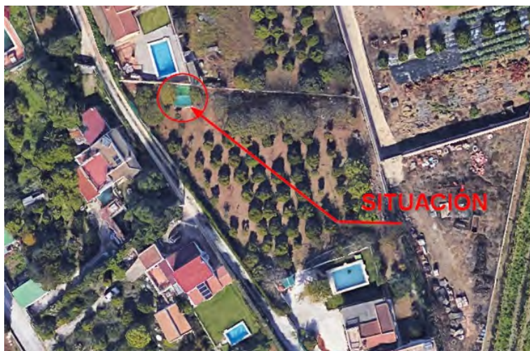
Fotografía aérea del año 2016 situando las obras denunciadas.
