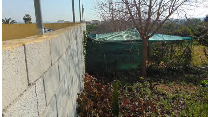
Fotografía de las obras denunciadas, realizada por el inspector urbanístico el 01/02/2017
