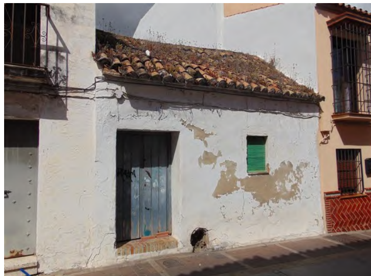
Foto 1. Vista exterior de la edificación tomada desde Calle Doctor Fleming
