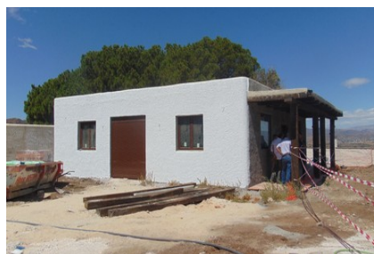
Nueva construcción: módulo 2
