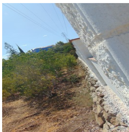
Fotografías esquina Noreste de la parcela: incumplimiento distancias seguridad L.A.T. y poste en medianera (fotografías proporcionadas por las empresa INEDA).
