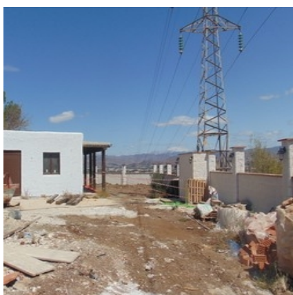
Fotografías esquina Noreste de la parcela: incumplimiento distancias seguridad L.A.T. y poste en medianera (fotografías proporcionadas por las empresa INEDA).
