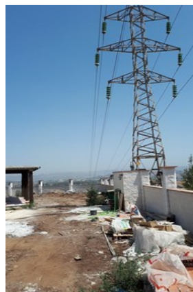
Fotografías esquina Noreste de la parcela: incumplimiento distancias seguridad L.A.T. y poste en medianera (fotografías proporcionadas por las empresa INEDA).
