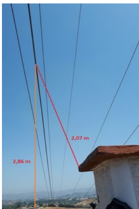
Fotografías esquina Noreste de la parcela: incumplimiento distancias seguridad L.A.T. y poste en medianera (fotografías proporcionadas por las empresa INEDA).
