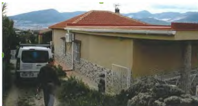
Foto 3. Ampliación de vivienda vista desde la cota superior de la parcela en donde se aprecia la unión con la vivienda antigua (04/03/2009)
