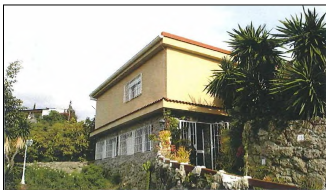
Foto 2. Ampliación de vivienda vista desde la cota inferior de la parcela donde se puede apreciar las dos plantas realizadas (04/03/2009)
