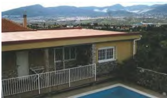
Foto 4. Ampliación de vivienda vista desde la cota superior de la parcela (04/03/2009)
