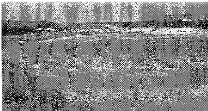
Foto 1: Vista de la explanación realizada en la parcela 35b del polígono 2
