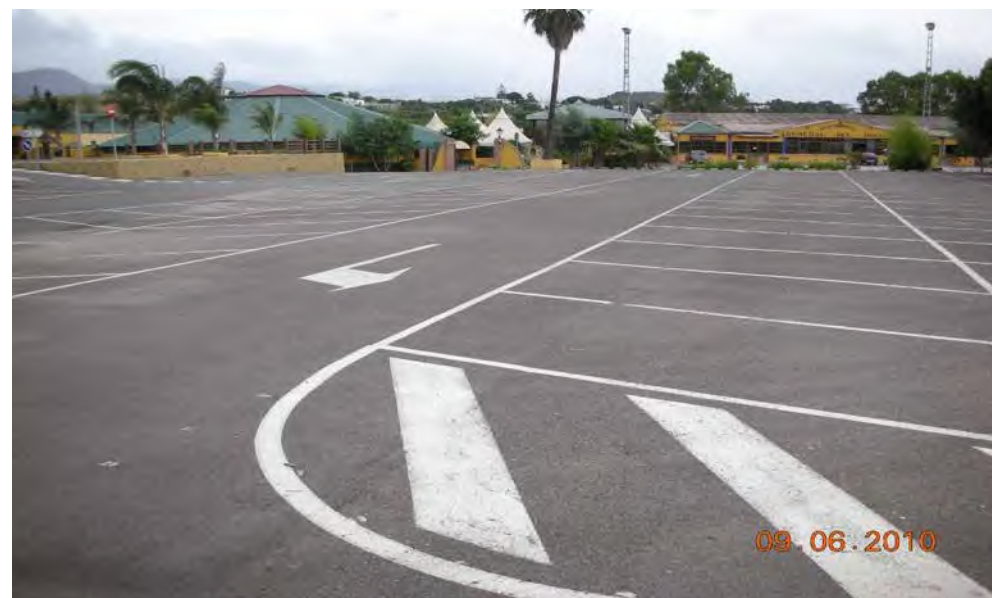
Zona de aparcamientos afectadas por las obras.
