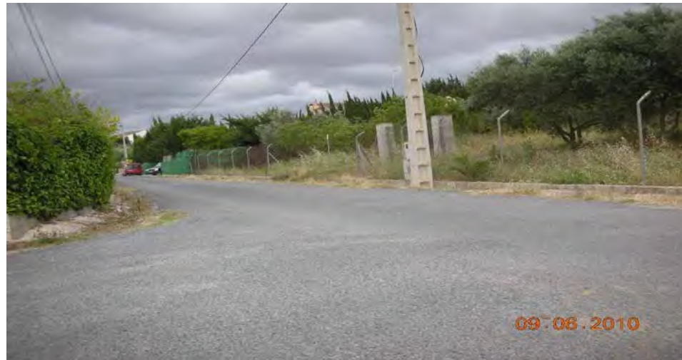
Barriada por la que el colector irá bajo la calzada
