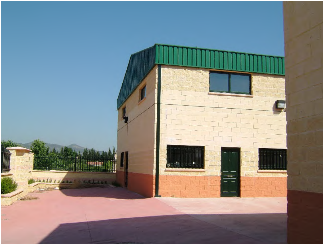
Acceso a naves y oficinas
