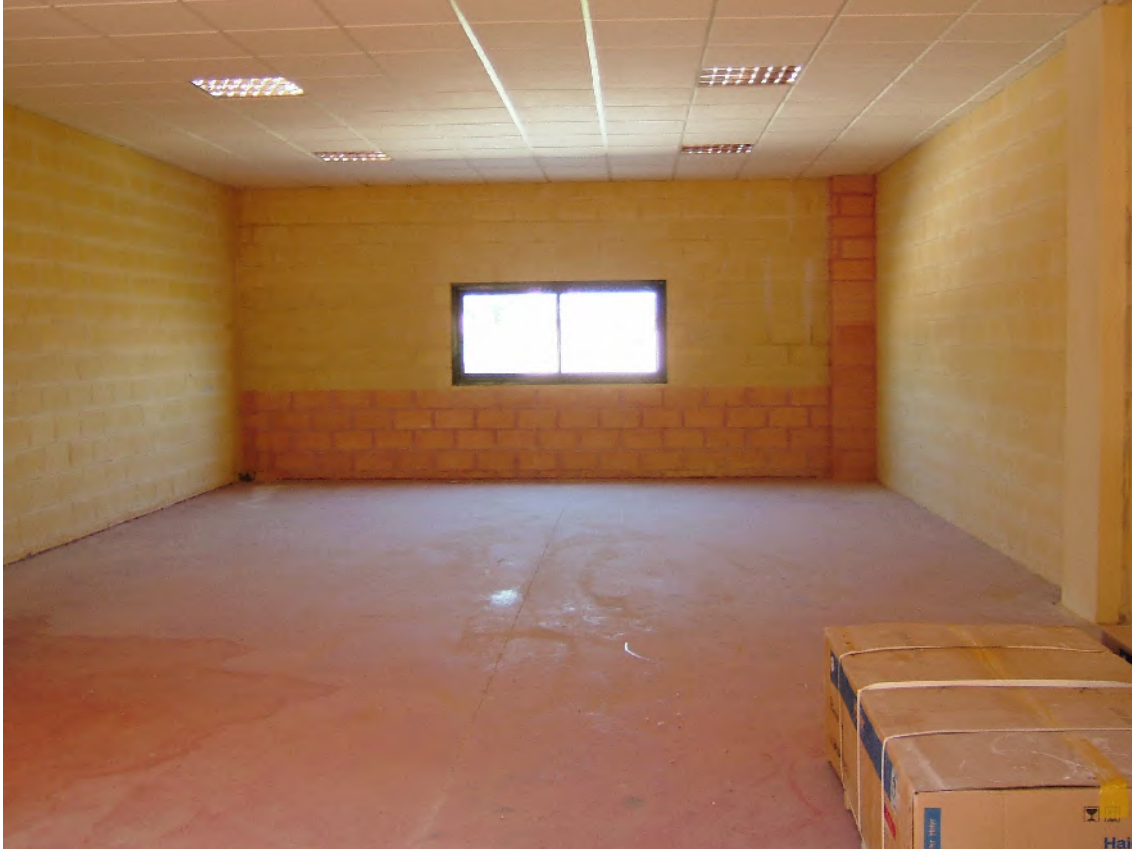
Aspecto general de las naves
