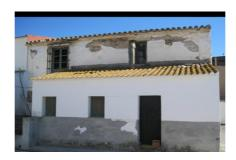
Al no poder accederse al interior, sólo se puede evaluar el estado de la misma desde el exterior, desde donde se comprueba que existen diferentes fisuraciones en la fachada, así como deterioro de los revestimientos, carpinterías, con presencia de humedades etc.
