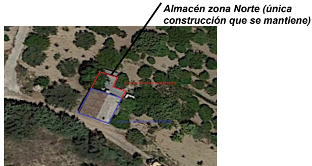
Google Earth Pro 06/06/2017. Estado de la vivienda anterior a la reforma y ampliación.
