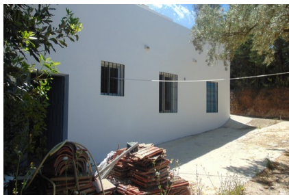
Fotografías exterior vivienda ampliada y reformada: elevación de altura zona norte y castillete de escalera
