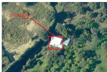
GOOL-ZOOM. Estado de la vivienda anterior a la reforma y ampliación
