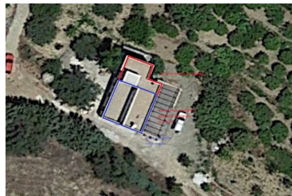
Google Earth Pro 17/06/2018. Estado de la vivienda actual donde se observan las reformas y ampliaciones realizadas.
