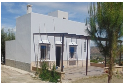
Fotografías exterior vivienda reformada y ampliada
