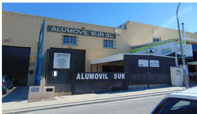
Foto 1. Vista de la estructura y del vallado objeto del expediente.
