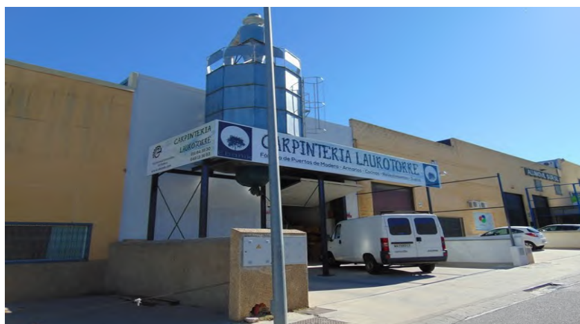
Foto 1. Vista de la estructura y del silo objeto del expediente
