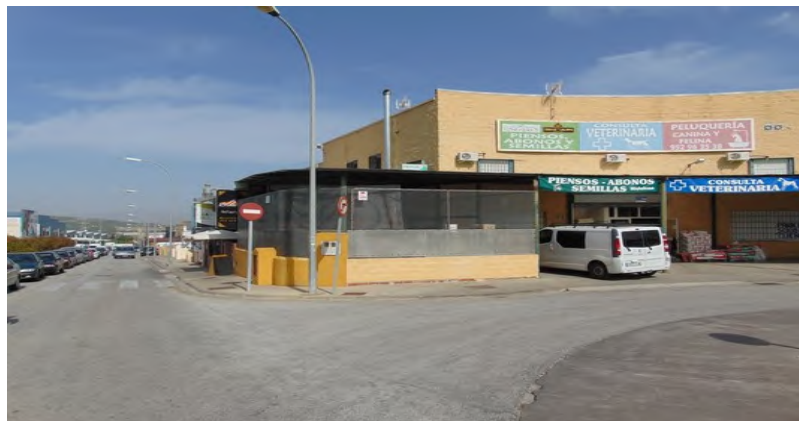
Foto 1. Vista de la estructura y del vallado objeto del expediente
