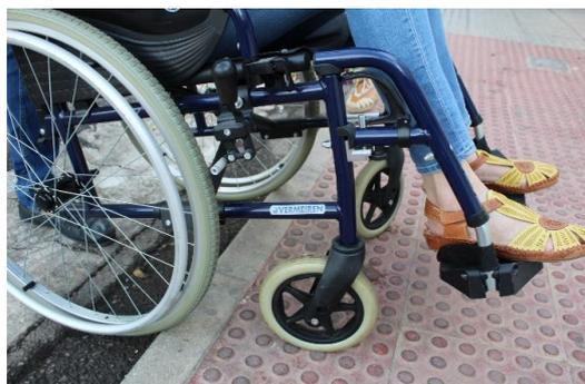
**Acera de difícil acceso por presentar escalón no corregido y pavimento podotáctil mal colocado puede provocar accidentes**
