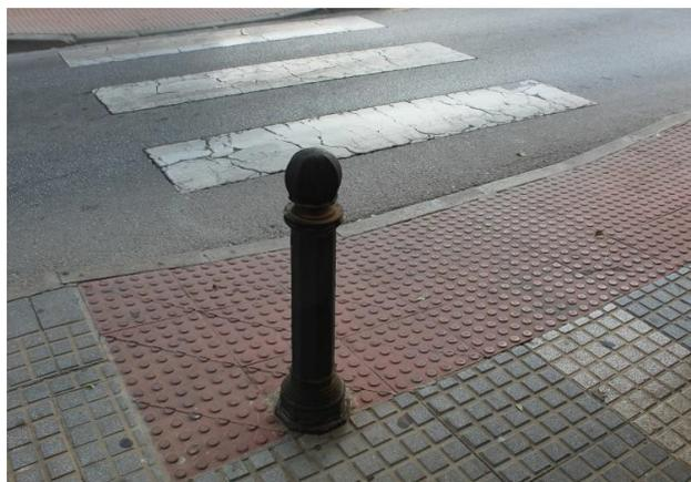
**Paso de peatones deteriorado, firme con indicación táctil de anchura excesiva y obstáculo en la zona de cruce**
