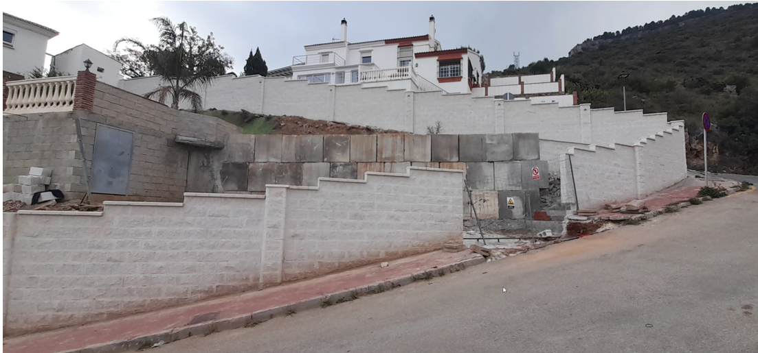
Fotografías de visita de inspección de fecha 09/02/2022
