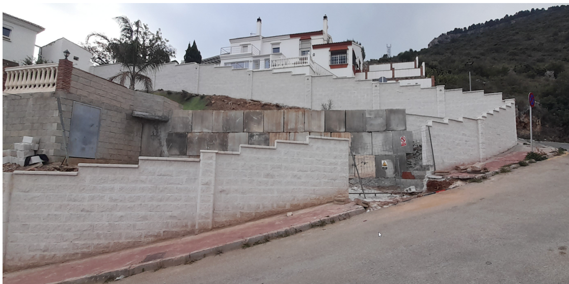
Fotografías de visita de inspección de fecha 09/02/2022
