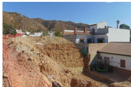
Fotografías visita de inspección (11/09/2019) desde el exterior de la parcela
