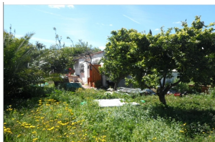
Estado de la vivienda anterior a la nueva construcción realizada (fachada principal)
