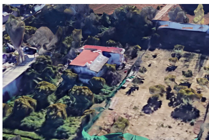
Estado de la vivienda anterior a la nueva construcción realizada (vista Sur)
