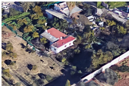
Estado de la vivienda anterior a la nueva construcción realizada (vista Norte)
