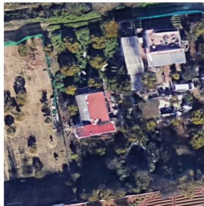
Estado de la vivienda anterior a la nueva construcción realizada (planta)
