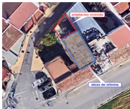
Situación de las obras realizadas en la parcela
