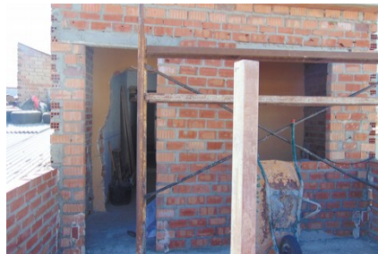
Fotografías obras de ampliación de vivienda
