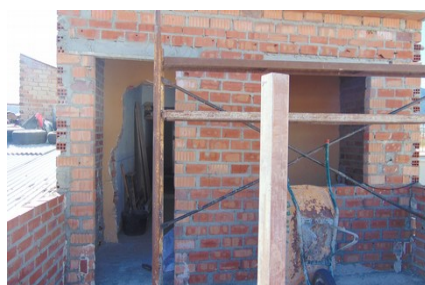
Fotografías obras de ampliación de vivienda
