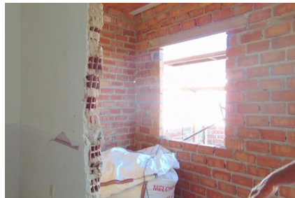
Fotografías obras reforma de vivienda
