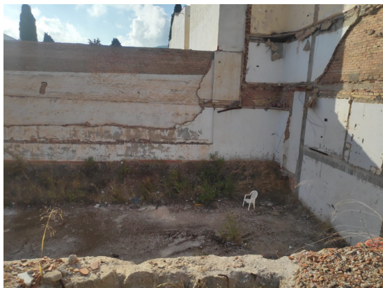
Fotografías tomadas durante la visita de inspección el 27/07/2023
