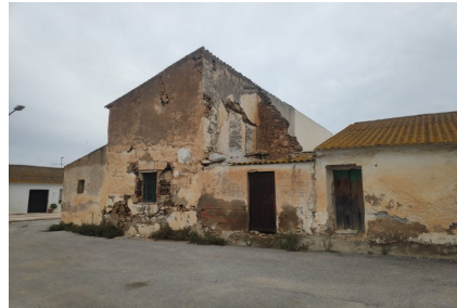
FOTO N.º 2. VISTA LATERAL DERECHA Y TRASERA DE LA VIVIENDA
